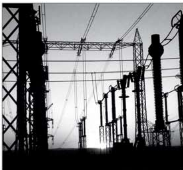
Construção de nova linha irá garantir melhorias no fornecimento de energia elétrica
