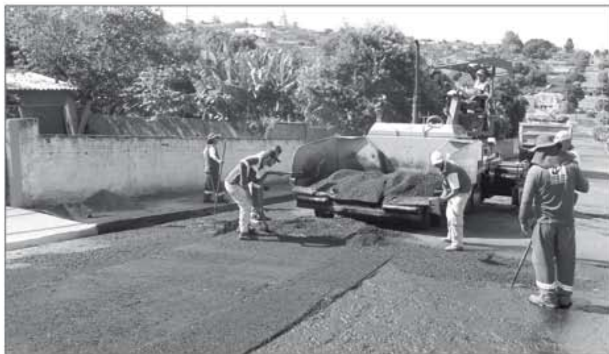
Recalpeamento de vias em CBUQ o mesmo utilizado em rodovias
