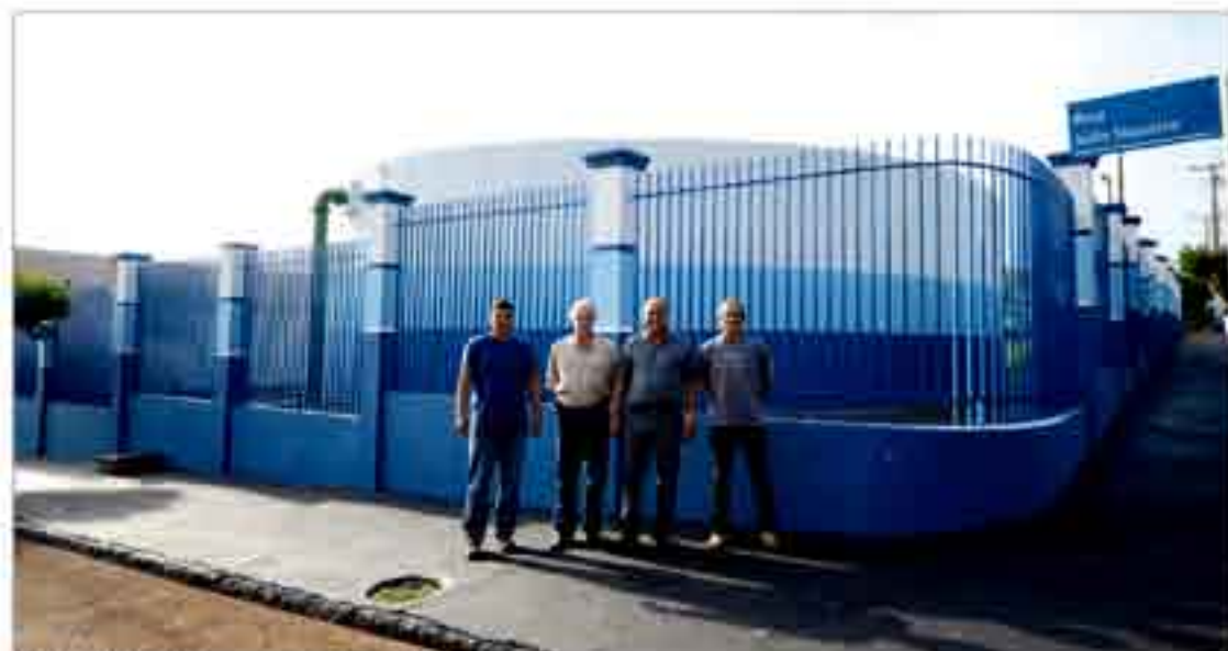
Melhorias de infraestrutura do Poço III
