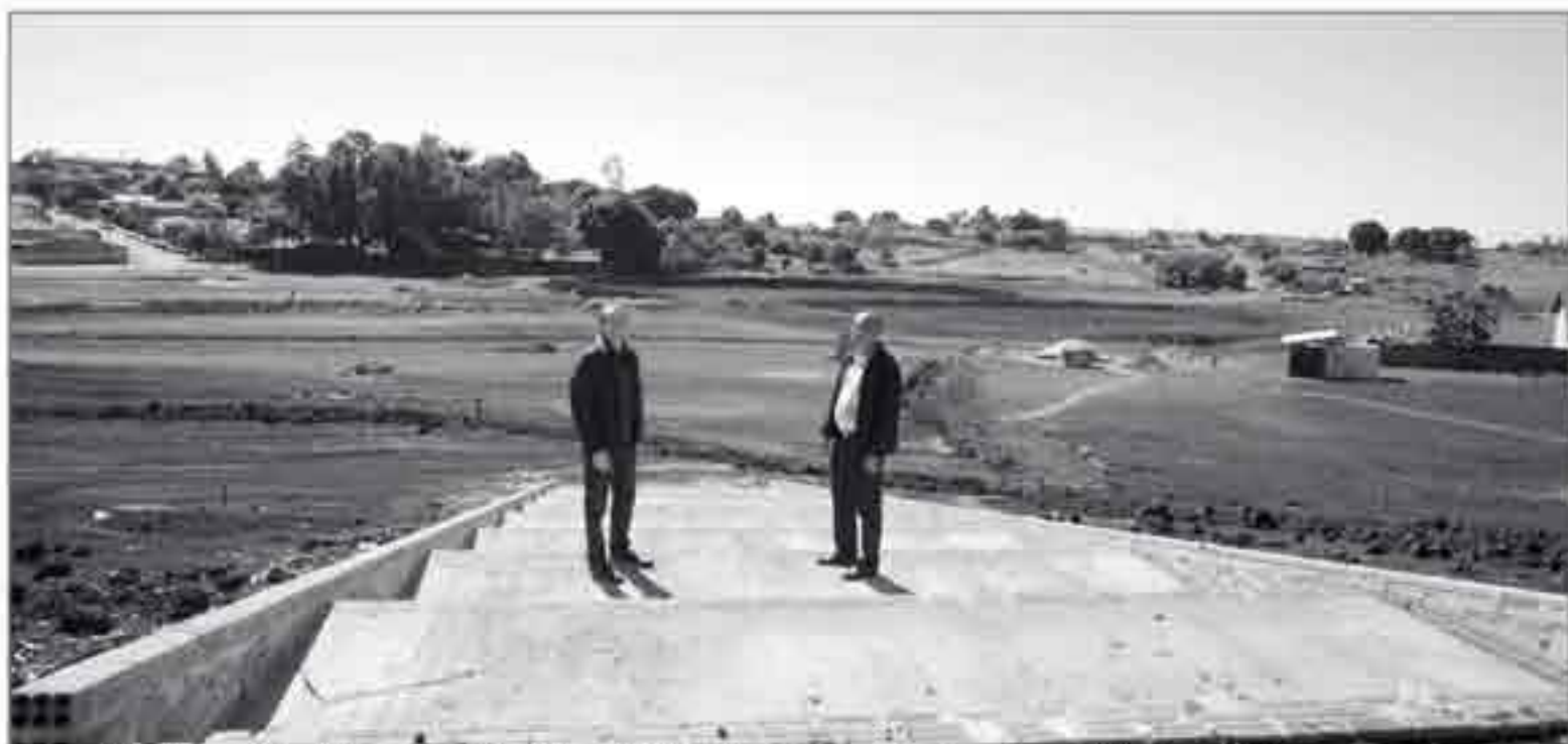
Prefeito de Bandeirantes, Celso Silva, acompanhado do diretor do SAAE (Serviço Autônomo de Água e Esgoto) Wilson Aparecido de Souza 'Mineiro', vistoriam obras do Parque do Povo
