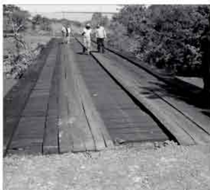
Ponte: construção e entrega em tempo recorde
