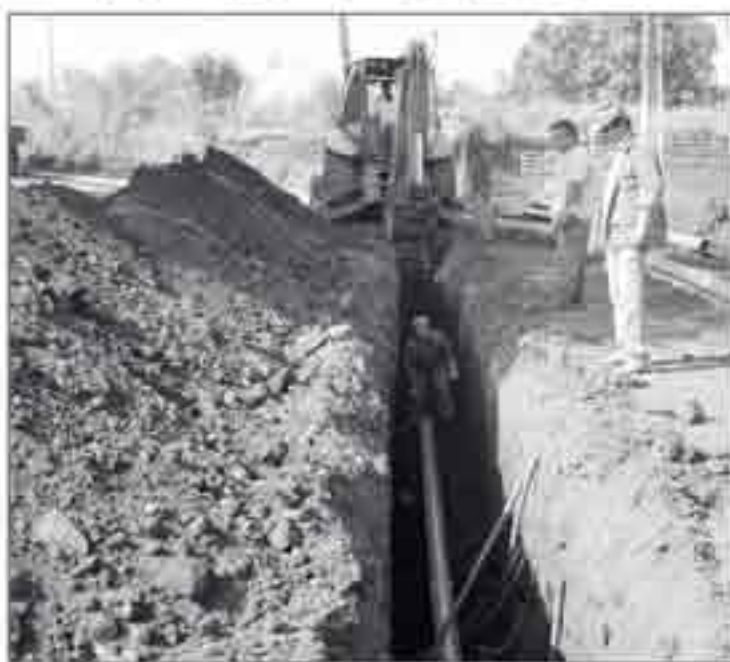
Servidores do SAAE trabalham na instalação de rede coletora de esgoto
