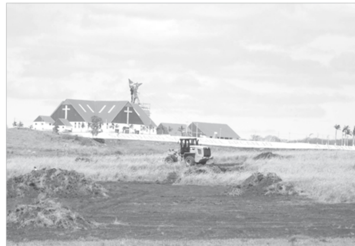
Área das 424 casas começa a ser limpa para receber terraplanagem
