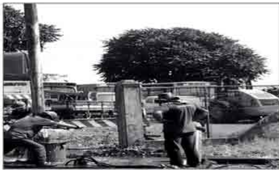
Equipes de trabalho realizam remoção de tubulações e bomba danificada
