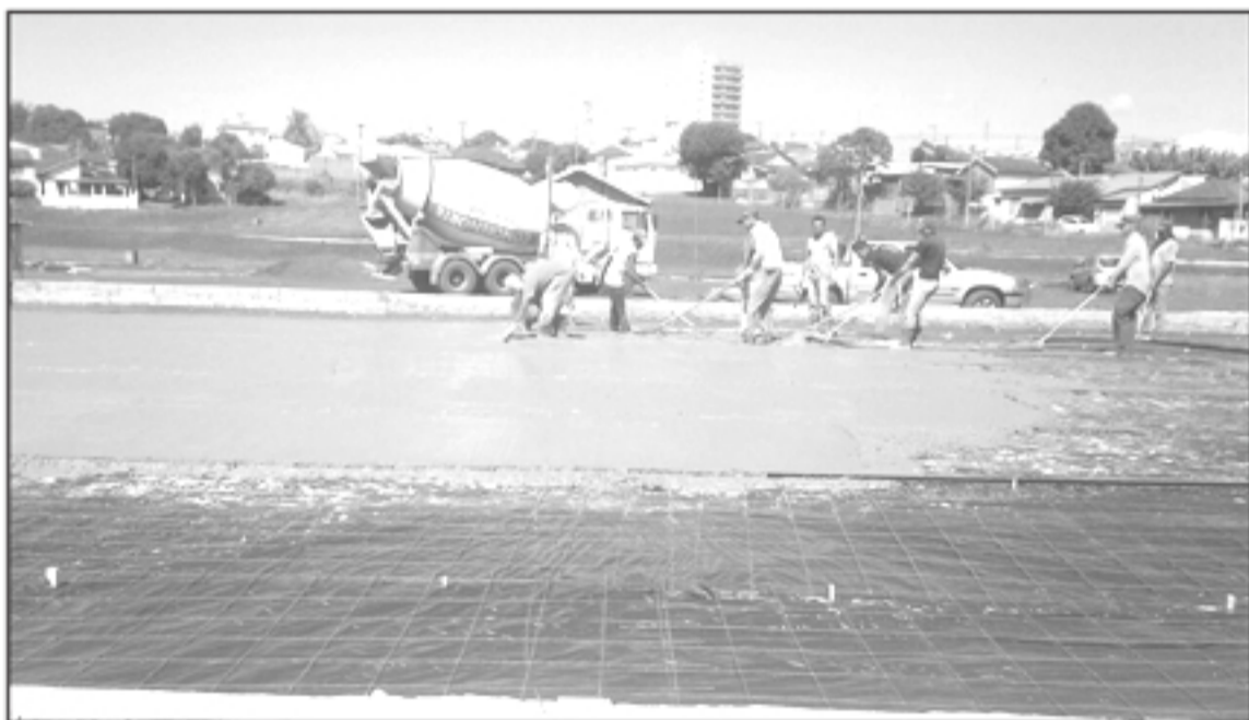
Serviço de concretagem e em seguida polimento para quadra poliesportiva
