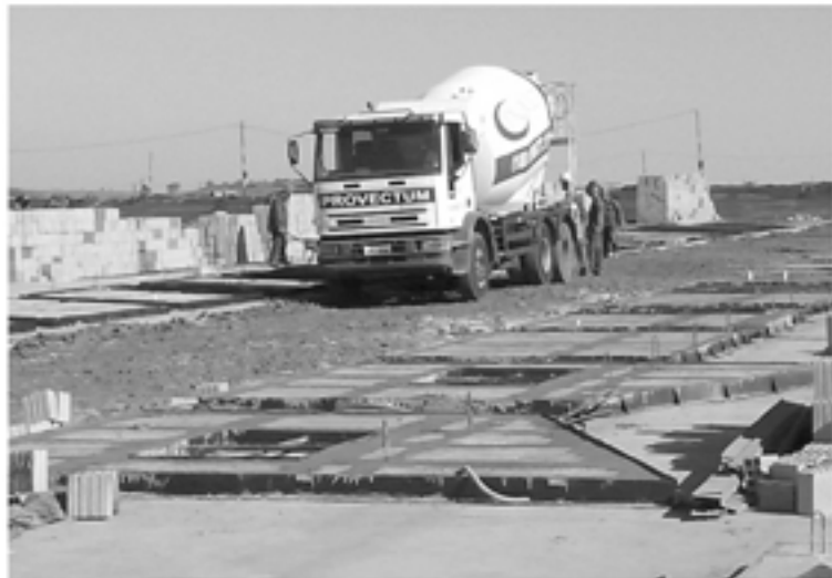
Conjunto habitacional com 424 moradias
