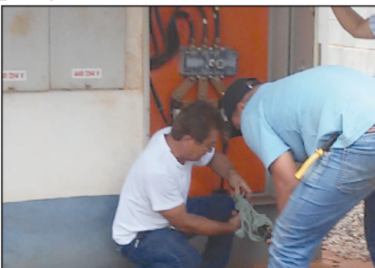
Servidores do SAAE recompõem os cabos elétricos para funcionamento do sistema de abastecimento
