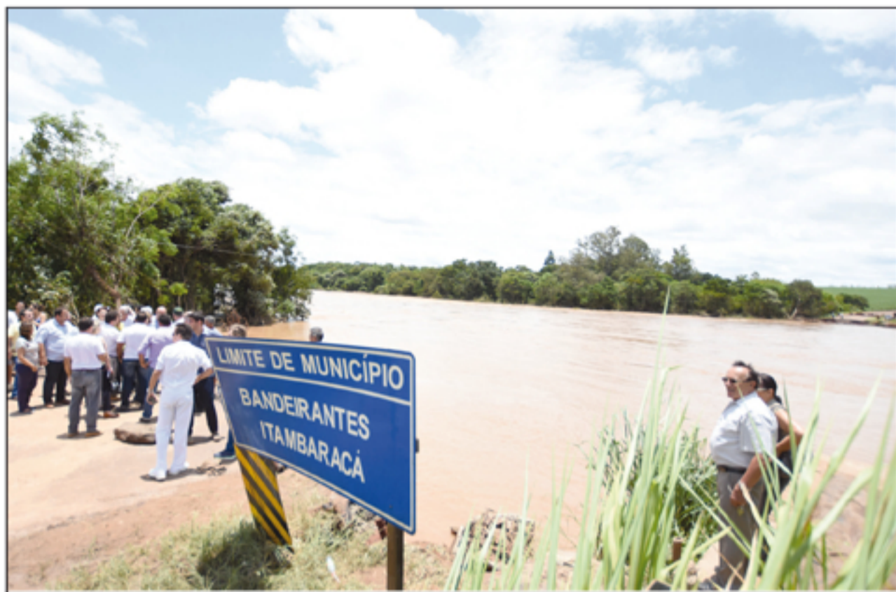
Ponte sobre o Rio das Cinzas desaparecida sob as águas
