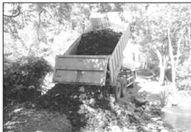
Prefeitura trabalha na recuperação e melhorias das estradas
