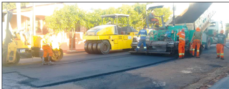
Início do recap asfáltico
