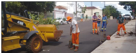
Fase final das obras com arborização urbana
