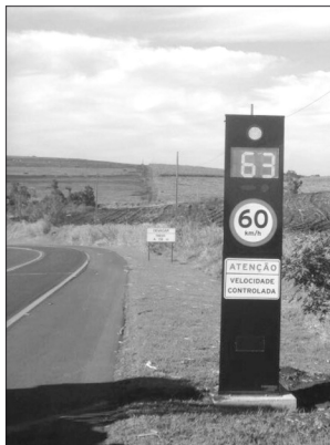
Instalação de equipamento na BR-369
