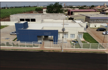
Vista aérea das novas instalações da Vara do Trabalho
