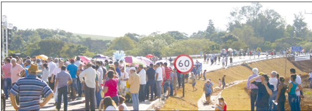
População regional participou da solenidade de inauguração e foram conferir as obras da nova ponte
