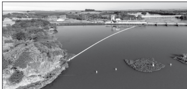
Estruturas ilegais às margens do reservatório Canoas I serão demolidas a partir do dia 06
