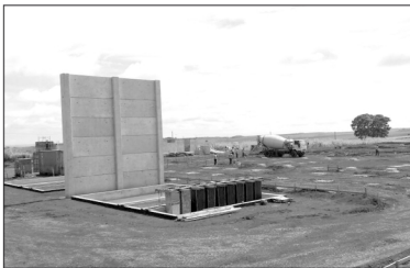
Empreendimento em Andirá/Barra do Jacaré está com 50% do projeto executado
